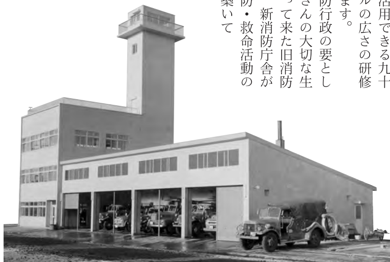
昭和37年建設時の旧消防庁舎
