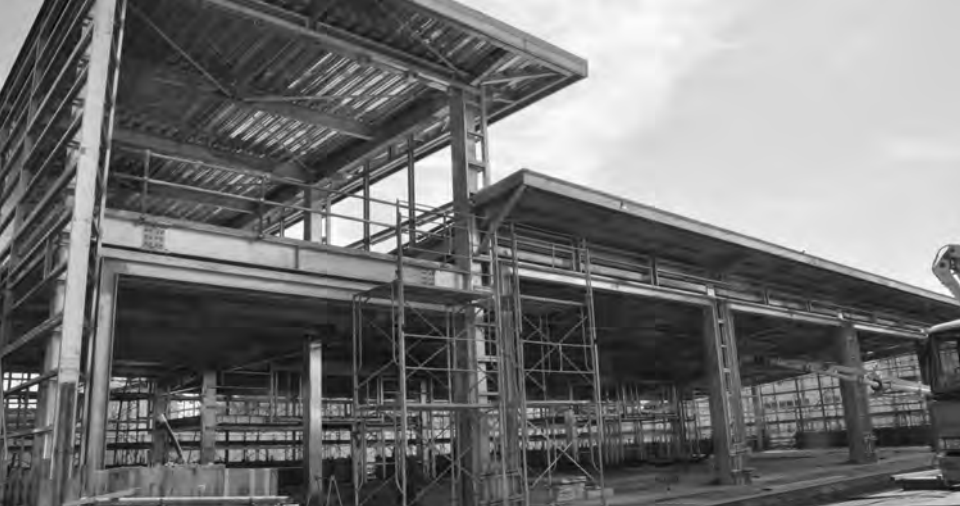
現在は一部2階建となる車庫の工事が進められている
