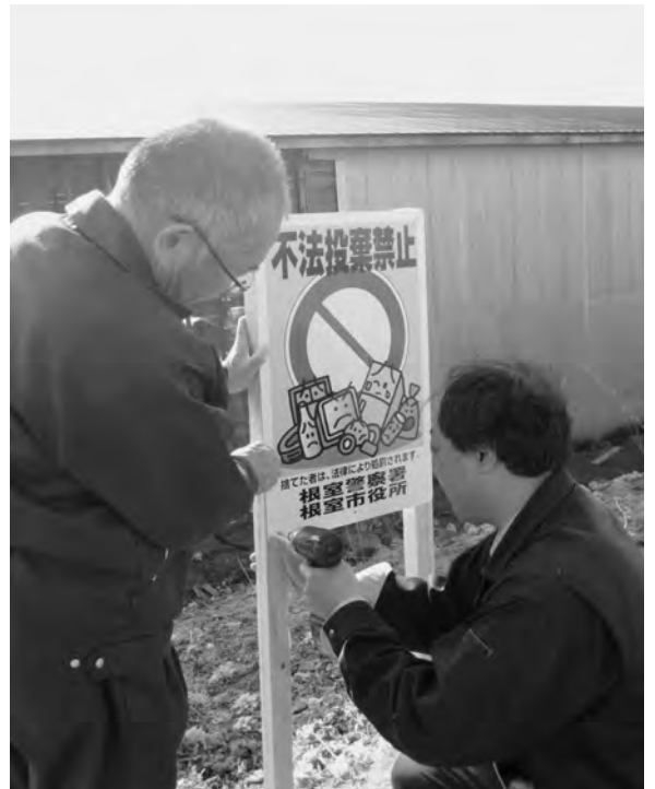
「不法投棄禁止」の看板を設置する市職員
