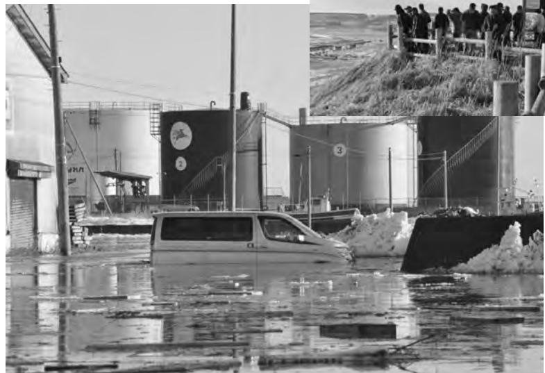
津波が防潮堤を越え道路が冠水 11日午後4時12分
