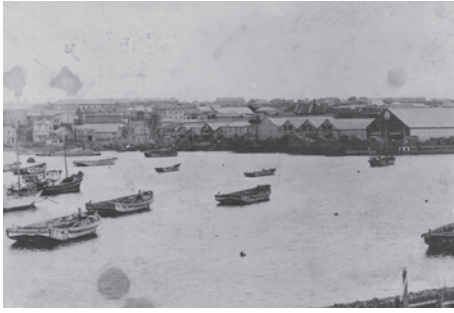
起工当時の根室港
