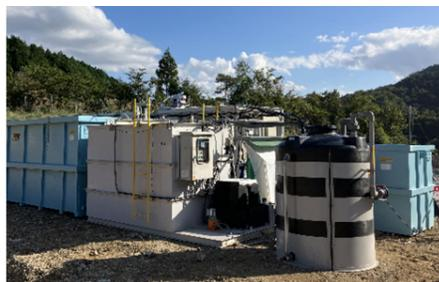
図:濁水処理装置設置例
