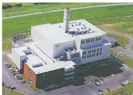
煙突が工場棟屋根上に設置の事例
