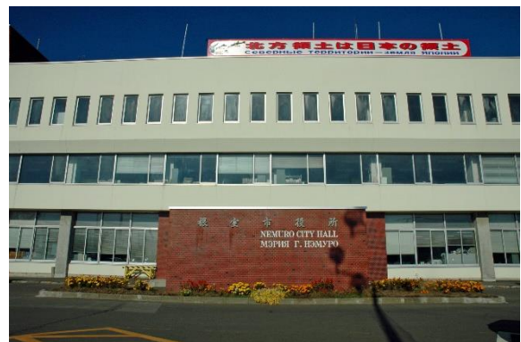
南から見た現庁舎
