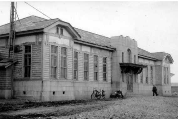
昭和6年（1931年）建設 根室町役場庁舎
