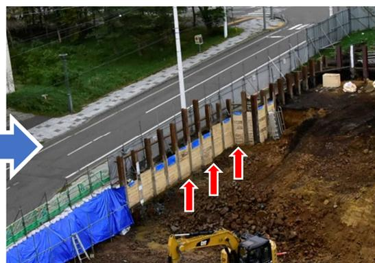
▲ 打ち込んだ杭（H型鋼）の間に矢板を差し込みます
