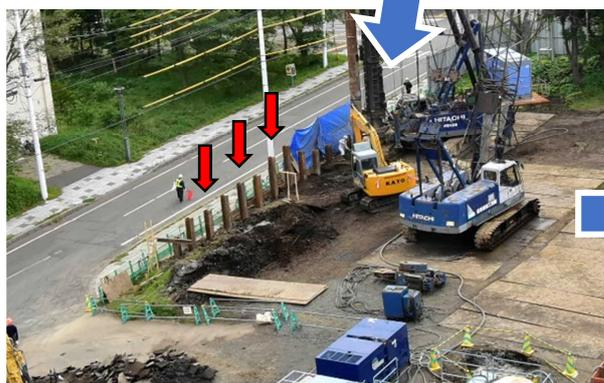
▲ 穴を掘った地面に杭（H型鋼）を打ち込んでいきます
