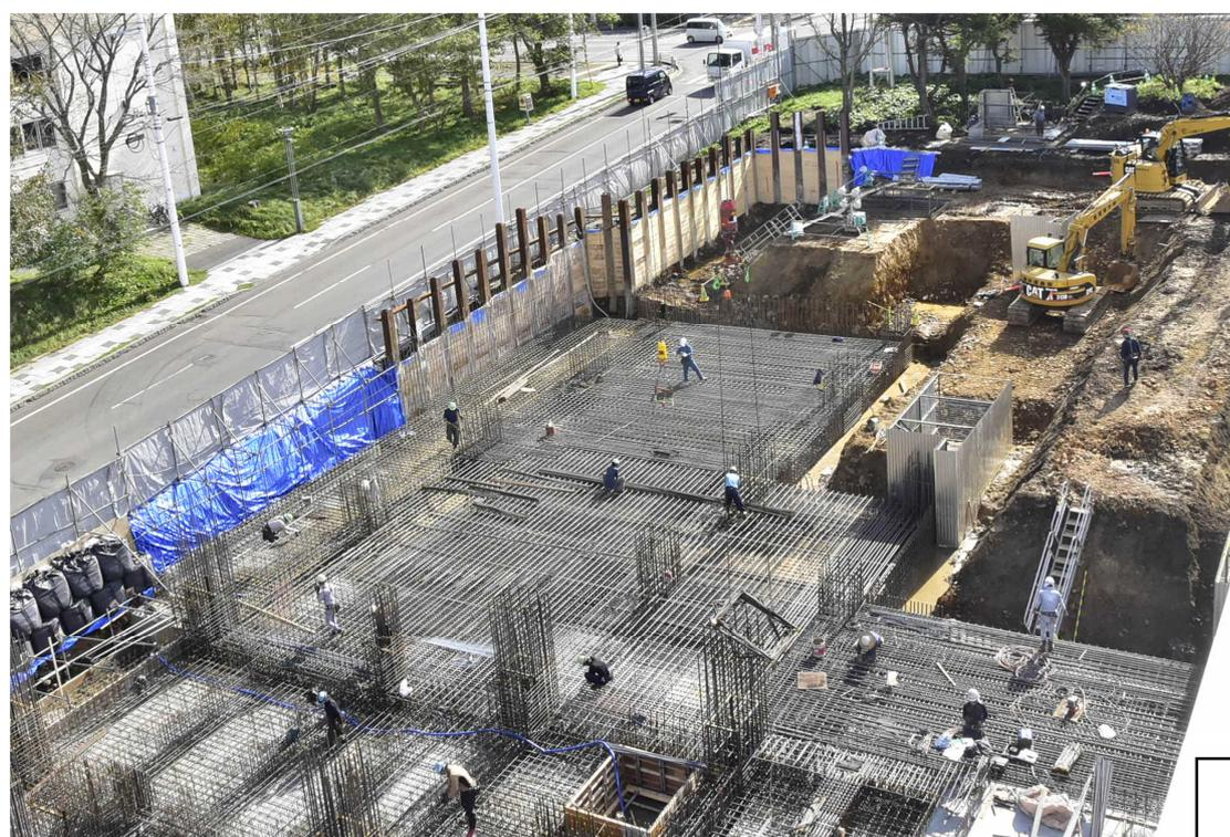
▼ 大量の鉄筋が1本ずつ組み立てられていきます
