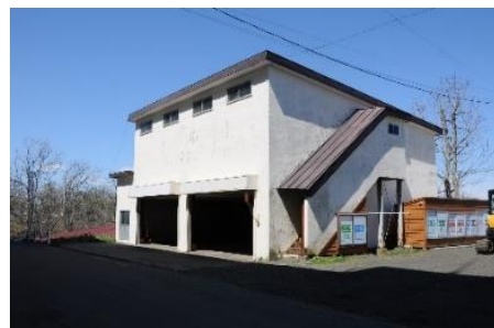
● 庁舎裏の車庫
