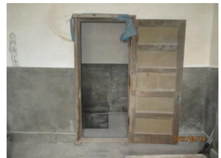
写真 2-10 内部仕切り壁及び片開木製扉
