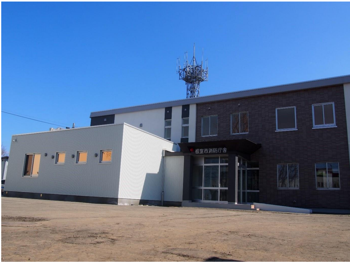
根室市消防庁舎
