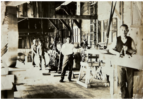
(5)- ㉗ 工場内部
