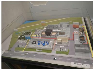
バイオマスガス化施設は地域の未利用バイオマスから可燃性ガスを生成し発電を行う。生成されたガスは発電に使用し、熱は各構成施設で活用される。生成後排出されるバイオチャーは農業用の土の改良剤として使用される。排出後のCO<sub>2</sub>はドライアイスなどにされ再利用している。
