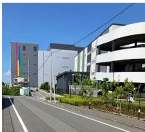
Google データーセンター
