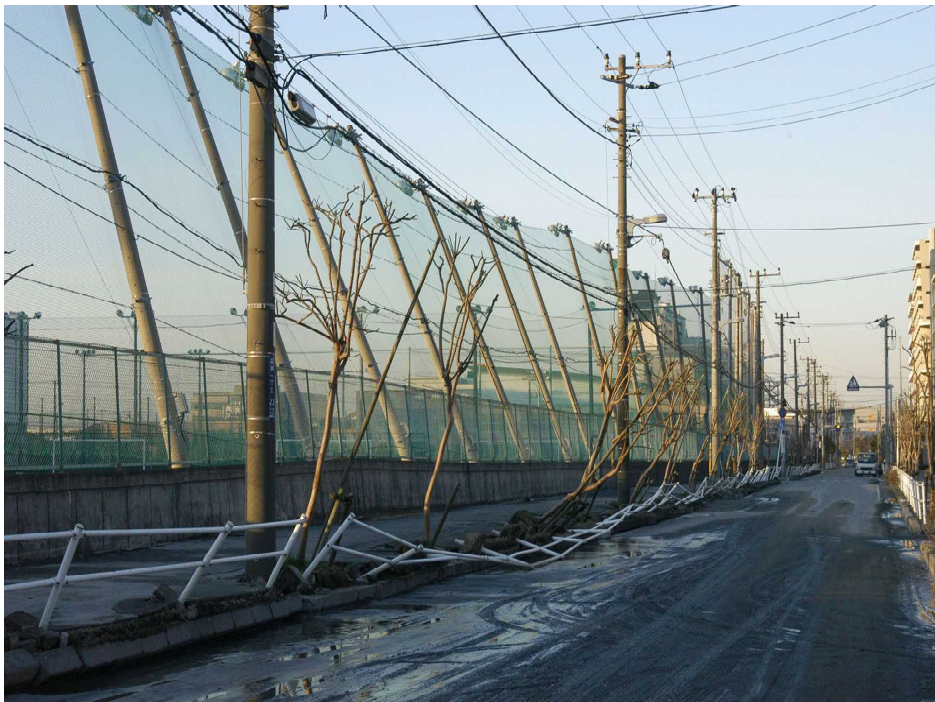
液状化現象による倒れたガードレール
