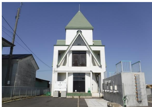
緑町雨水ポンプ場
