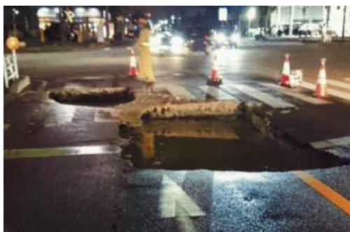
管路施設に起因した道路陥没事故の事例
