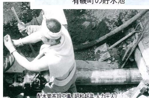
配水管布設工事(昭和46年 人力圧入)
