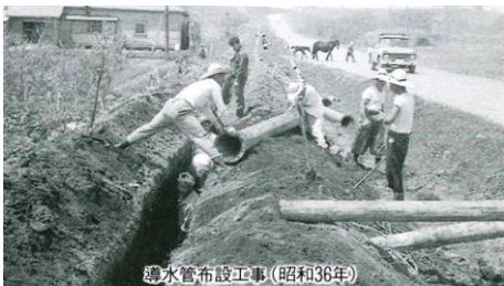
導水管布設工事(昭和36年)
