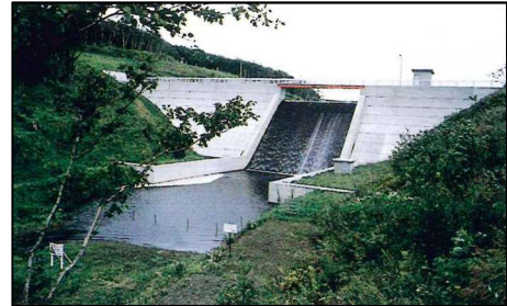
牧の内ダム(堤体部)
