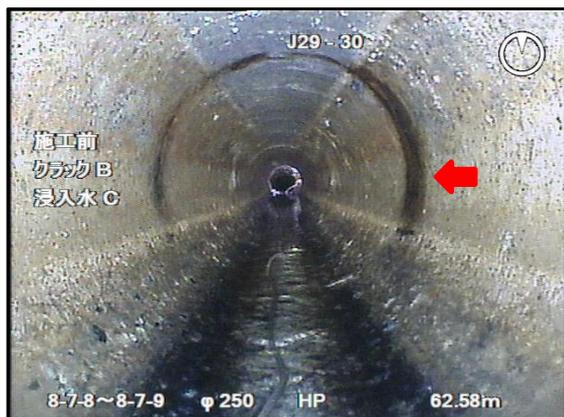
▲赤い矢印の部分に亀裂が生じているため、そこから地下水が浸入して黒く変色しています。
