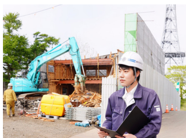
工事現場を 監督する様子
