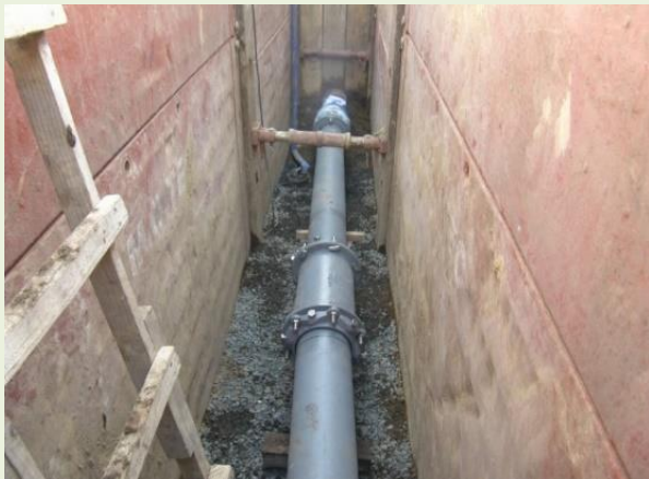
道道花咲港線配水管布設替工事
