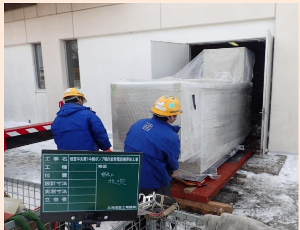
根室中央第1中継ポンプ場自家発電設備更新工事
