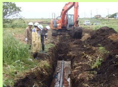
市道友知沖根婦配水管布設替工事
