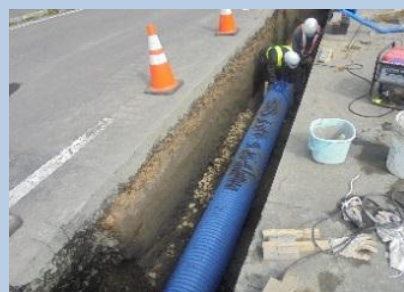
浸水対策排水ポンプ樹接続管渠工事
