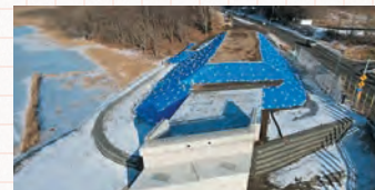
▲令和6年度 別当賀改良工事
