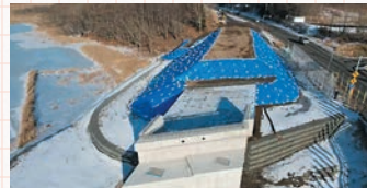
▲令和6年度 別当資改良工事
