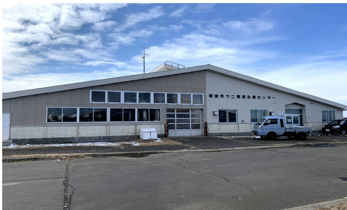
根室市ウニ種苗生産センター外観
