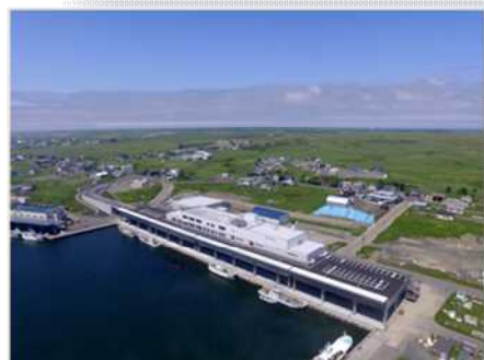
歯舞漁協新施設・人工地盤施設 全景
