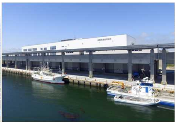
人工地盤海側
