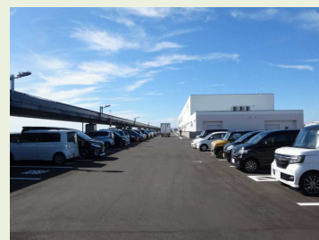
人工地盤2F（駐車場）
