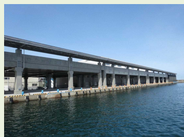
人工地盤海側 屋根付き岸壁
