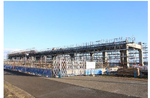
建設中の新施設（屋根付き岸壁）
