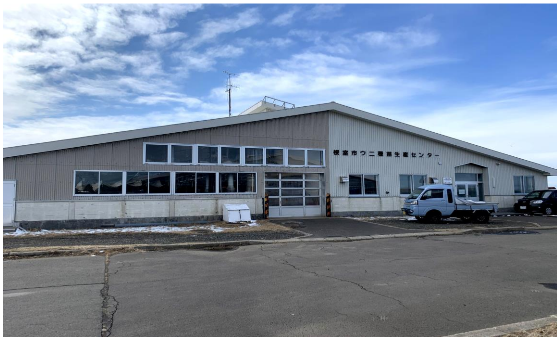
根室市ウニ種苗生産センター外観
