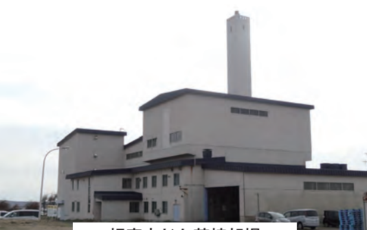
根室市じん芥焼却場
