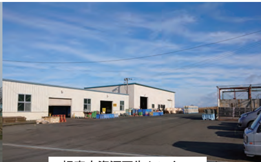
根室市資源再生センター
