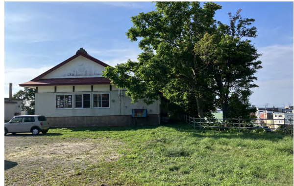
写真 2-22 区画も無く駐車エリアが不明確
