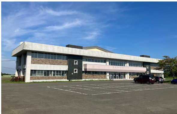
写真 2-5 耐震補強未実施の施設
