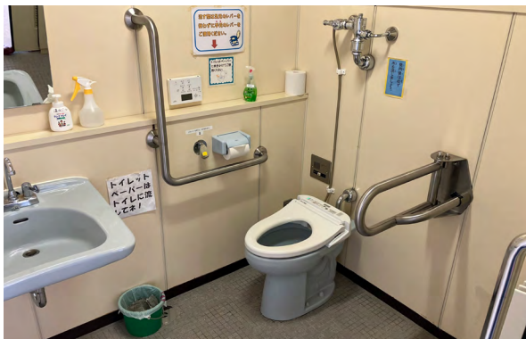
写真 2-35 オストメイト未対応の多目的トイレ
