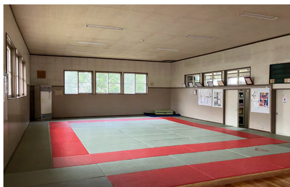
写真 2-17 十分な広さの無い格技場
