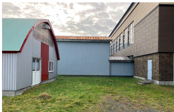
写真 2-39 青少年センターとの非接続
