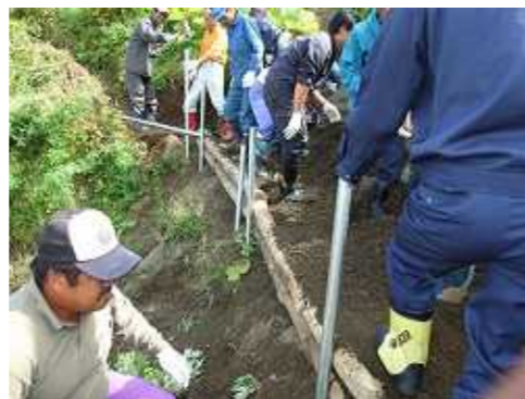
危険な場所を整備
